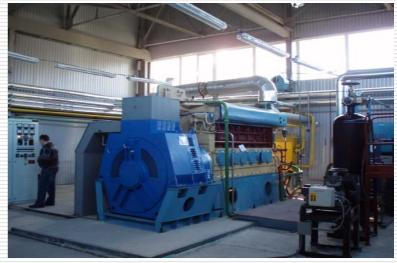
Когенерационные установки для комбинированного производства электрической энергии и тепла созданы на базе стационарных газовых двигатель-генераторов (ДвГА) с утилизацией теплоты выпускных газов, охлаждающей двигатель воды, масла и наддувочного воздуха.
